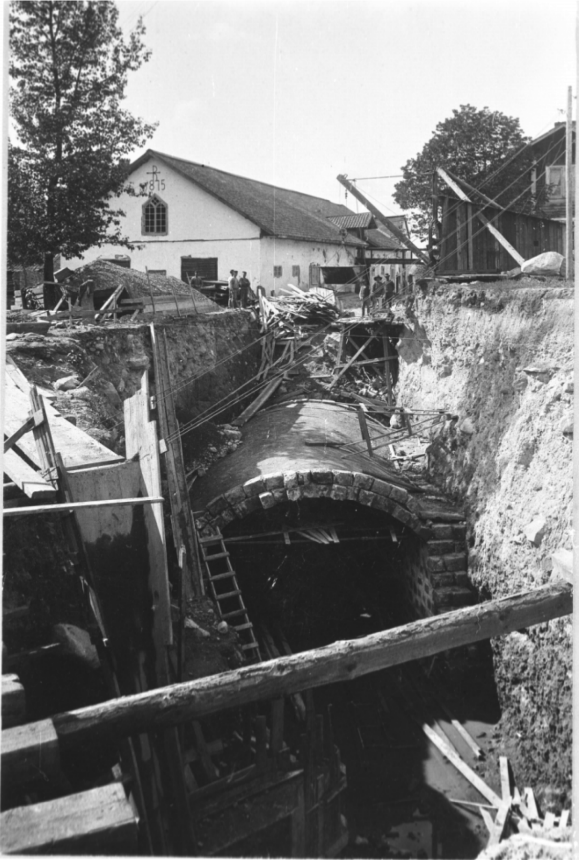
Foto: Ludvika Hembygdsförening 5823 Bild 1 Tunnelschakt och byggnation
