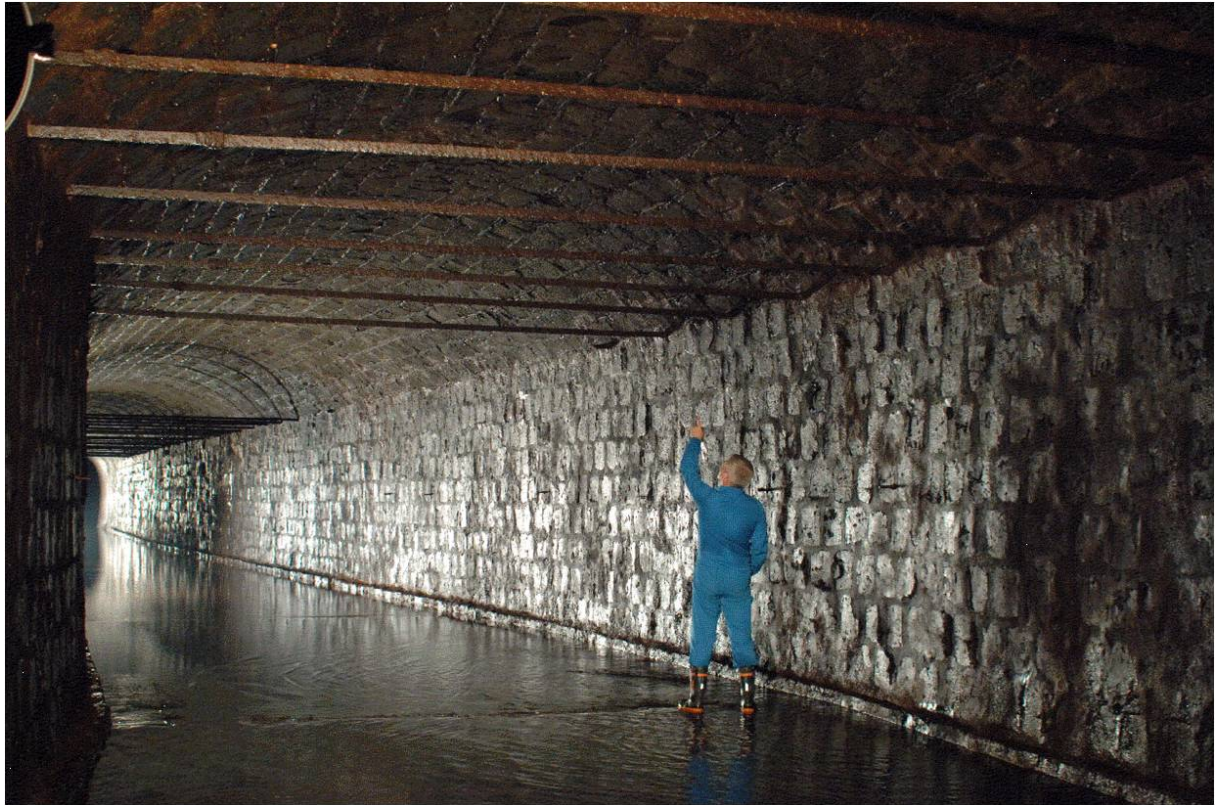
Foto: Bengt Bäcklin Västerbergslagens Kraft AB Bild 3 Normalsektion av slaggstenstunneln
