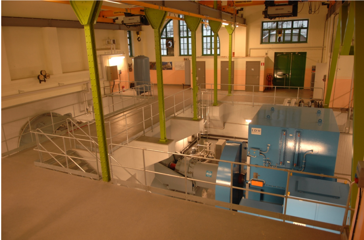
Foto: Bengt Bäcklin Västerbergslagens Kraft AB Bild 11 Kaplanaggregat efter ombyggnaden 2007
